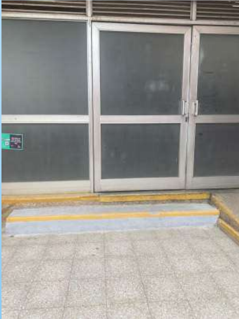
Reparación de peldaños
