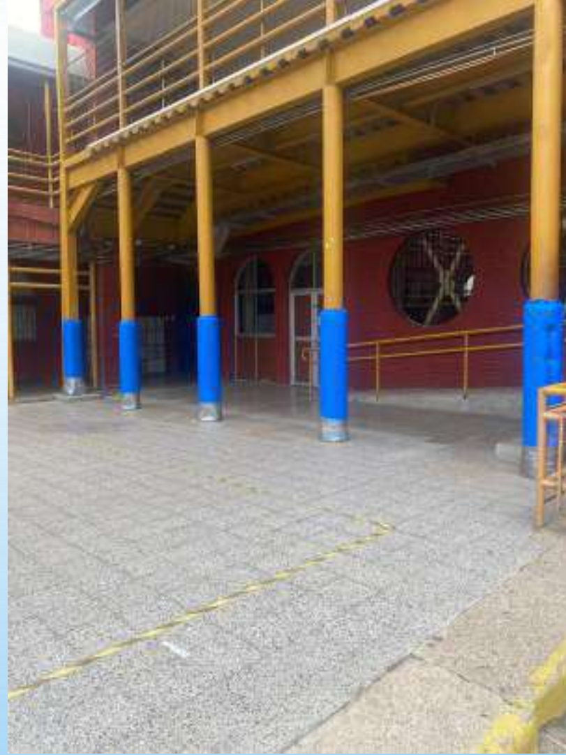
Protectores en columnas patio E. Media
